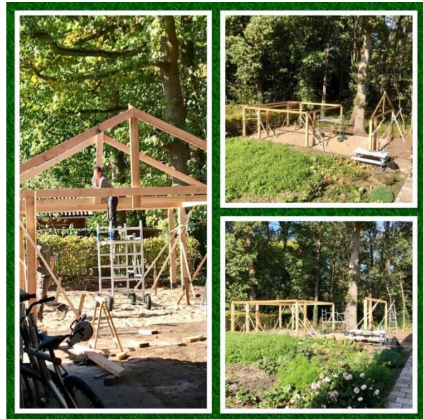
(De schuur in aanbouw - oktober 2018)
