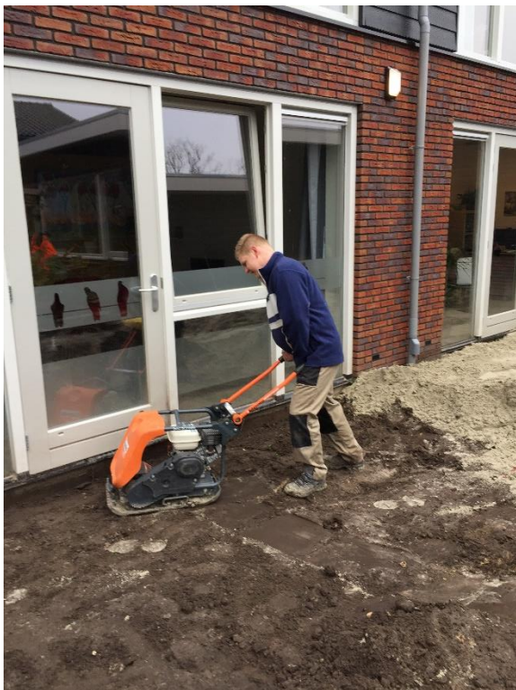
(Veel grondwerk bij het aanleggen van de eerste tegelpaden – januari 2018)
